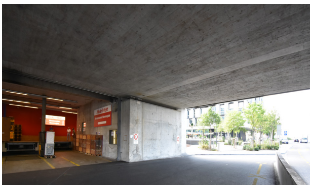
La livraison se fait par la rue Meret Oppenheim, au niveau de la rampe de livraison sous la passerelle.
