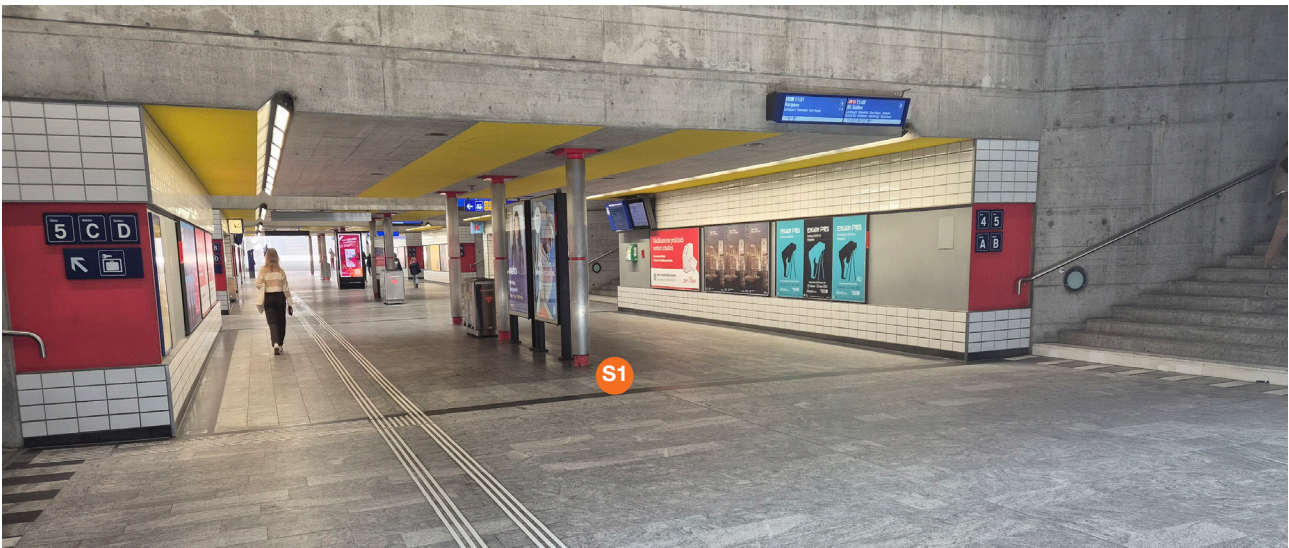
S1 Verteilpunkt, Bereich Ladenzone, zwischen Gleis 4/5, Unterführung
